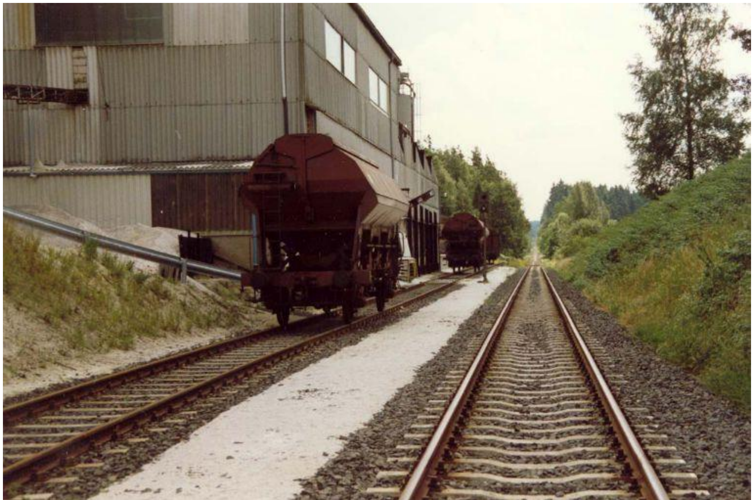
Gleisanschluss der Firma Schmelitz an der Strecke Tirschenreuth-Liebenstein mit Blick Richtung Liebenstein.
