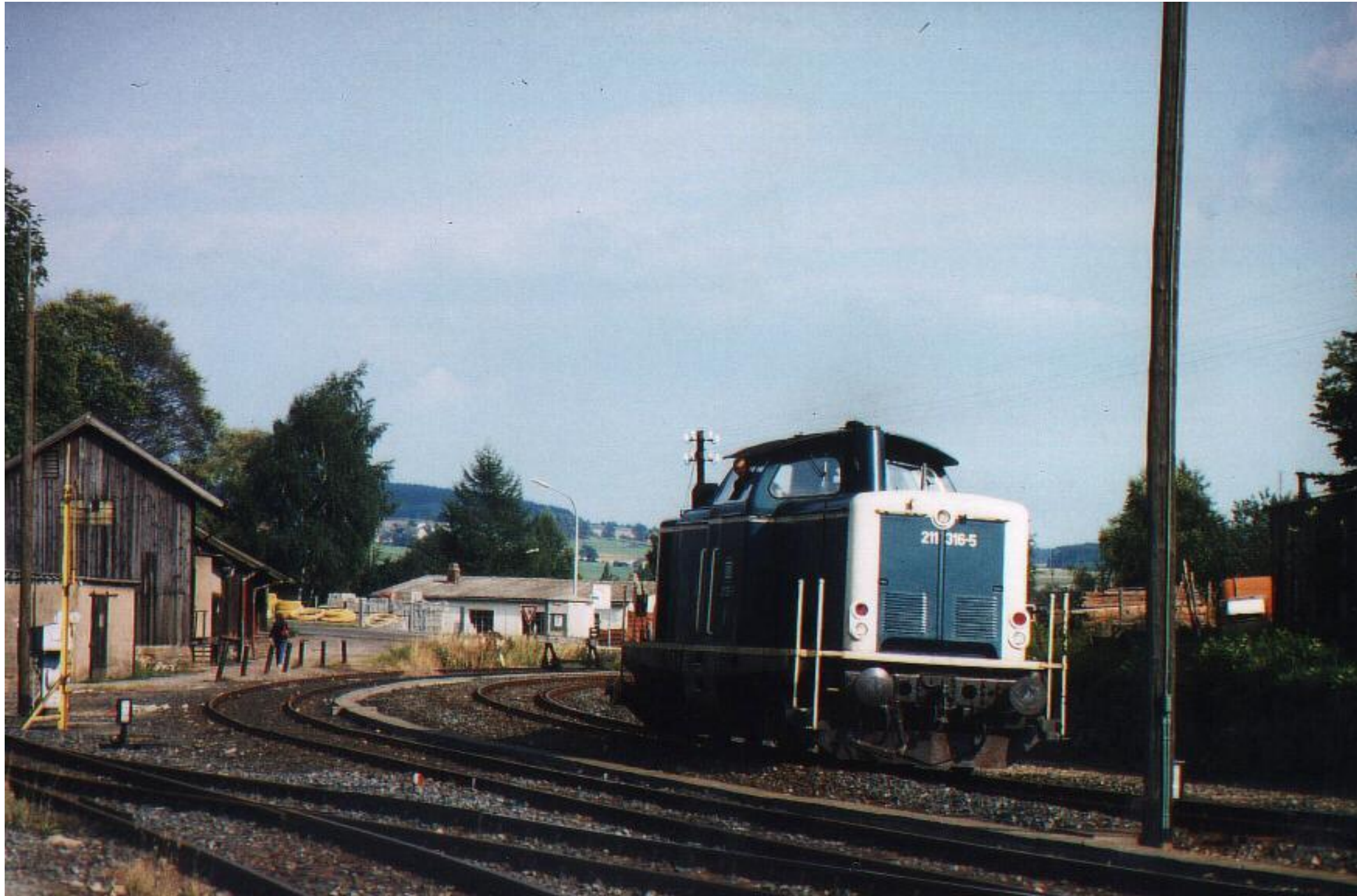
Bis zum Ablauf des Winterfahrplans 1982/83 verkehrten die meisten Personenzüge nach Floß mit BR 211 und drei 4achsigen Umbauwagen. Am 25. August 1981 setzt 211 316 im Bahnhof Floß über Weiche 9 und 12 gerade um. Die Blickrichtung ist nach Osten Richtung Vohenstrauß. Das Gleis links neben der Lok ist das Reststück der 9 Jahre vorher rückgebauten Stichbahn nach Flossenbürg. Im Hintergrund ist auch das alte hölzerne Raiffeisenlagerhaus zu erkennen, das heute einen Ehrenplatz im Oberpfälzer Freilandmuseum Neusath-Perschen bei Nabburg hat.
